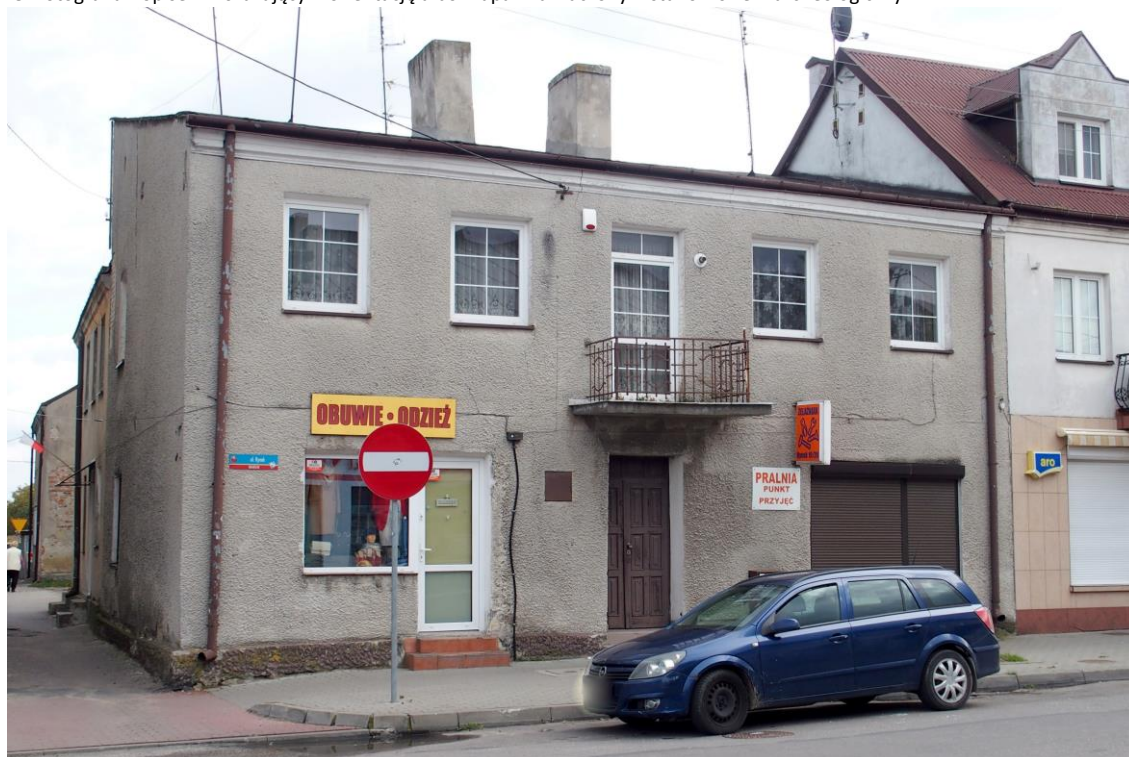
Widok budynku od północnego - zachodu
