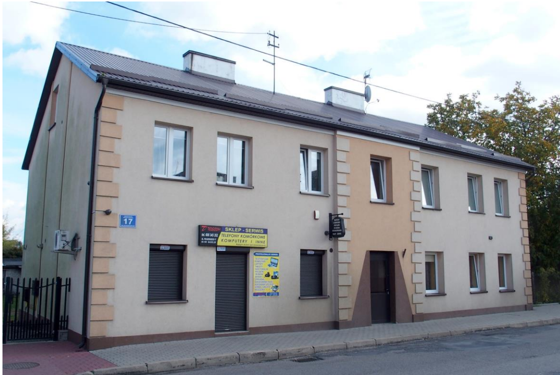
Widok budynku od północnego - zachodu
