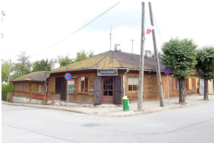
Widok budynku od południowego - zachodu
