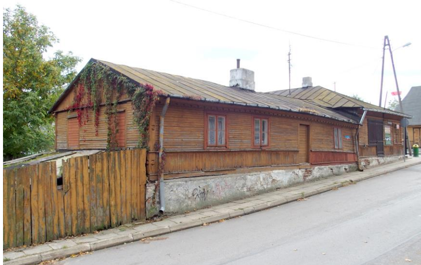
Widok budynku od północnego - zachodu
