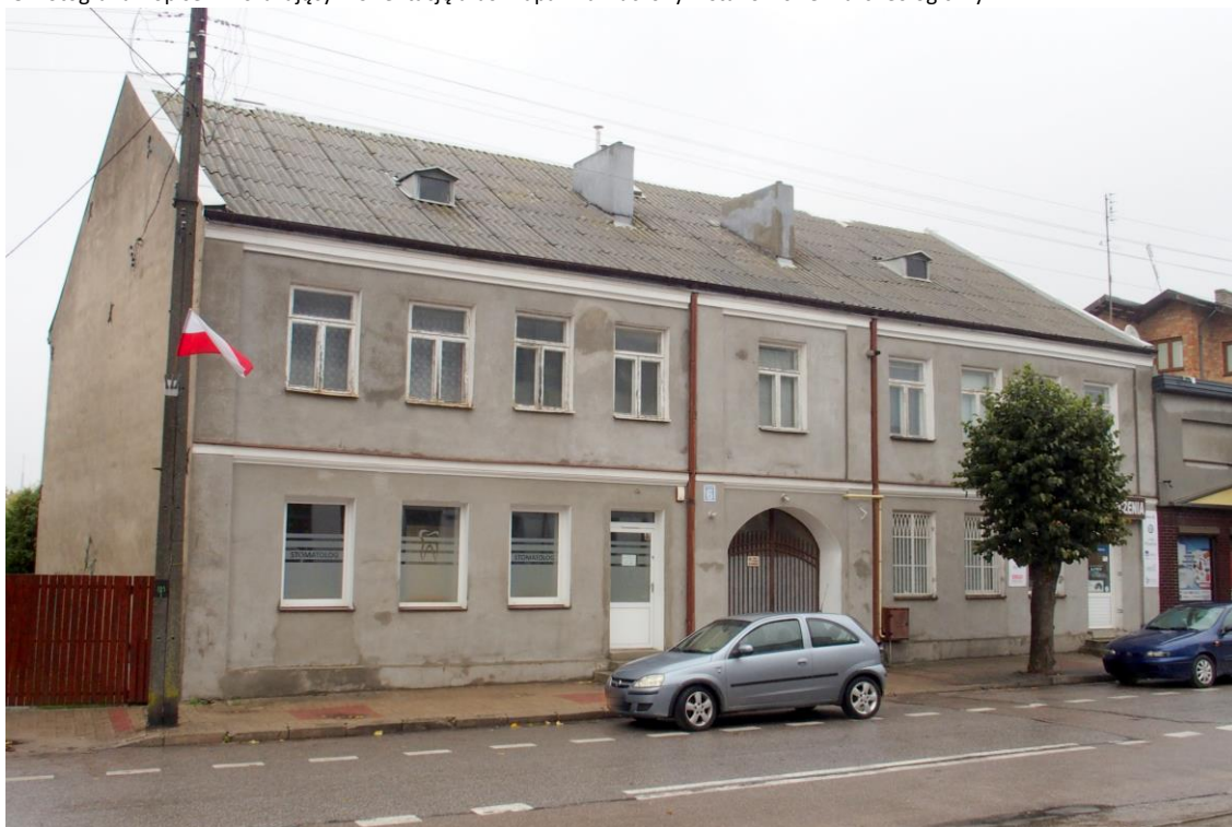
Widok budynku od południowego - zachodu
