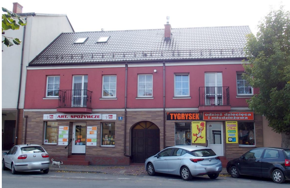
Widok budynku od północy
