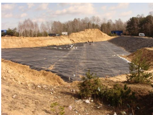
Budowa II kwatery składowiska odpadów innych niż niebezpieczne oraz kompostowni w Jaskółowie (2012 r.)
