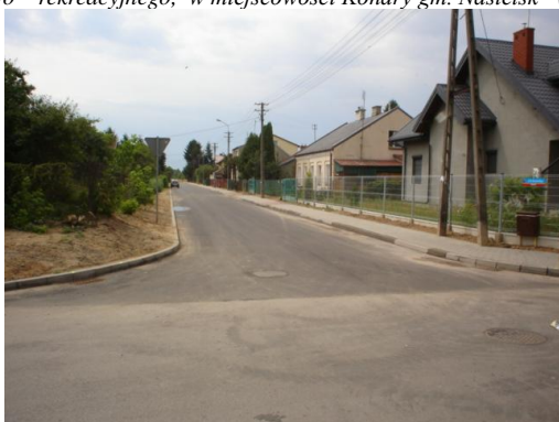
Budowa kanalizacji przy ul. Broniewskiego (2014 r.)
