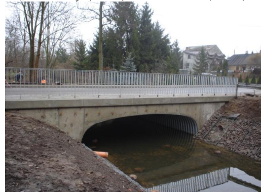
Przebudowa mostu przy ulicy Żwirki i Wigury w Nasielsku (2014 r.)
