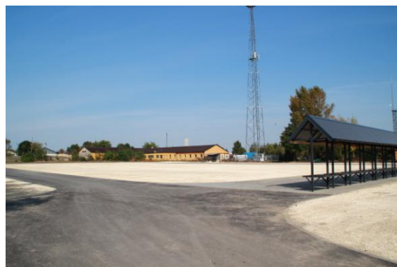
„Przebudowa targowicy miejskiej w Nasielsku, ul. Lipowa” (2014 r.)
