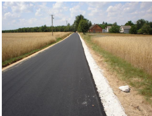
Modernizacja drogi gminnej w Lelewie (2014 r.)
