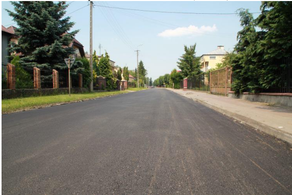
„Modernizacja (remont) ulic w Nasielsku” (2013 r.)
