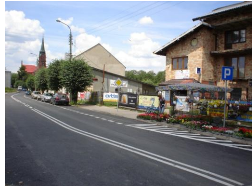
„Modernizacja (remont) ulic w Nasielsku” (2013 r.)
