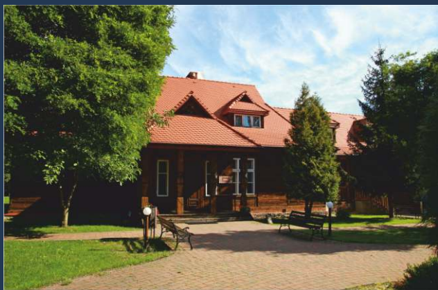
Budynek byłej szkoły z Dębinek.
