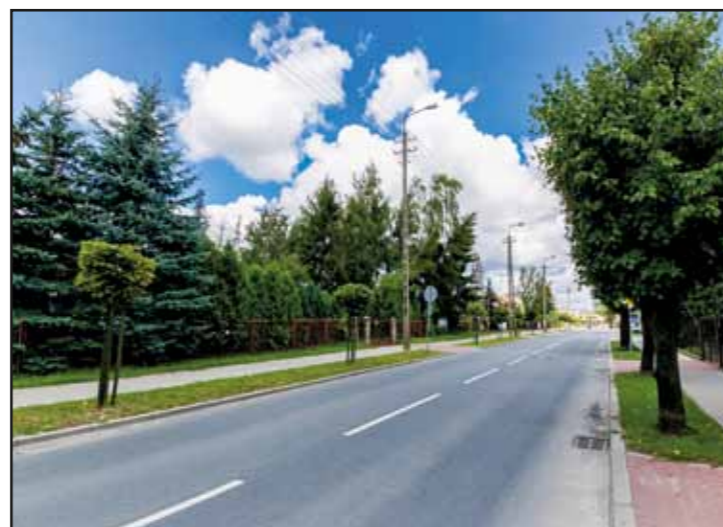
Budowa kanalizacji sanitarnej w ul. P.O.W. w Nasielsku
