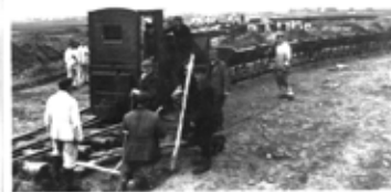
Bau der Startbahn
