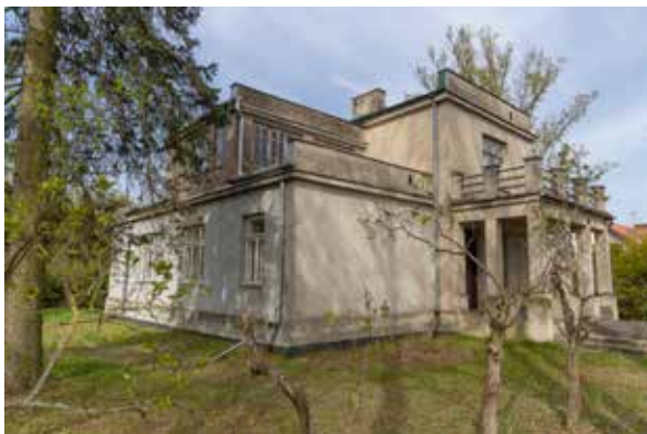
Zdj. 30. Fotografia fasady południowej willi Wacława Oleksiaka przy ul. Ogrodowej 4. Stan współczesny. Autor Krzysztof Miller
