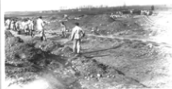
Bau der Startbahn
