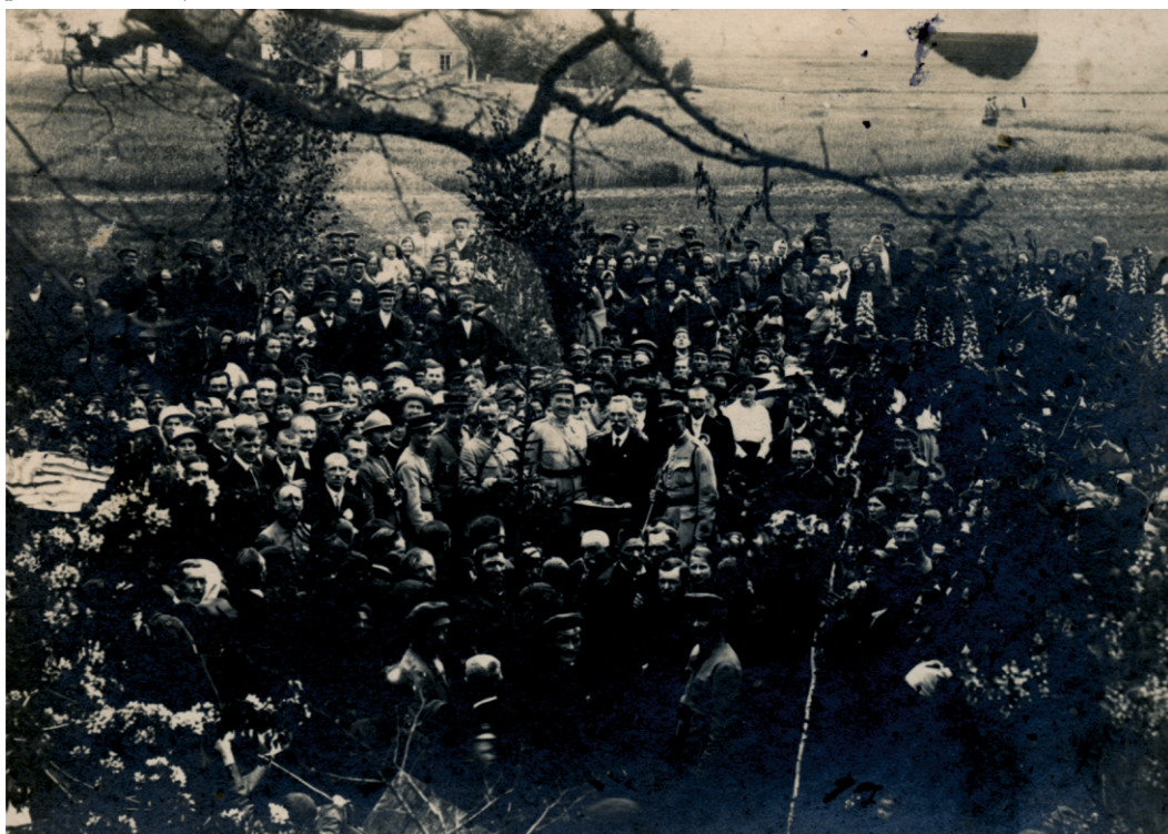
Symboliczne zainicjowanie budowy linii kolejowej do Pułtuska, maj 1919 r.
