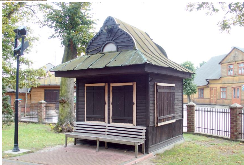
Widok budynku od północnego - zachodu
