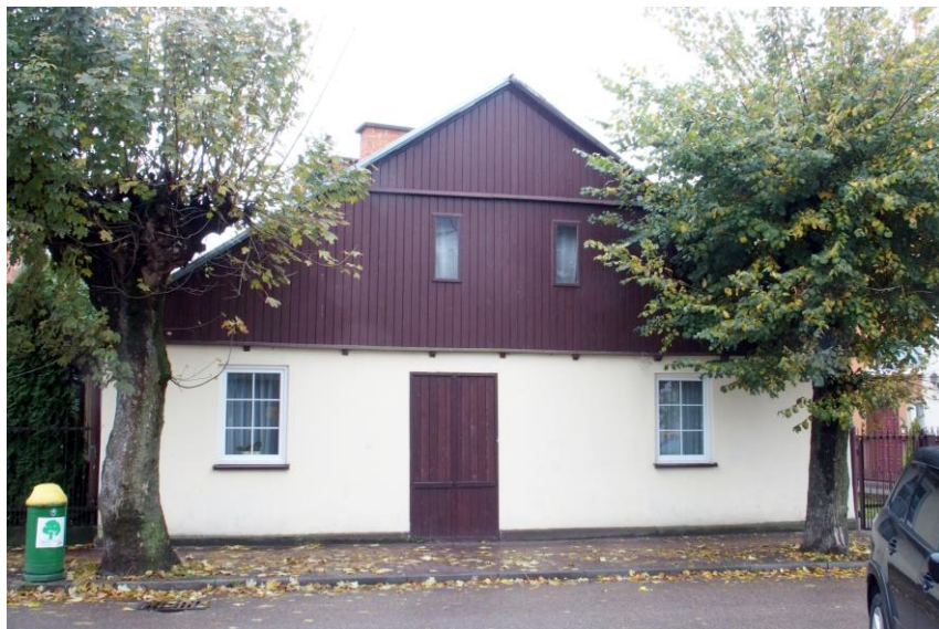
Widok budynku od północnego - wschodu
