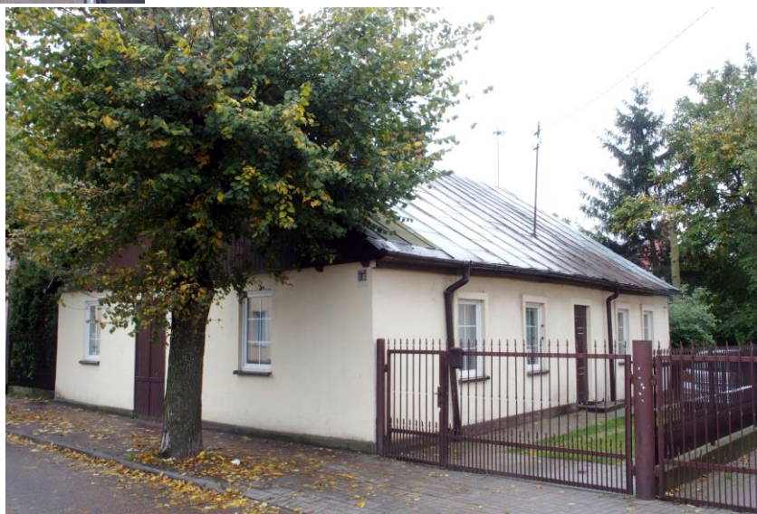
Widok budynku od północnego - zachodu
