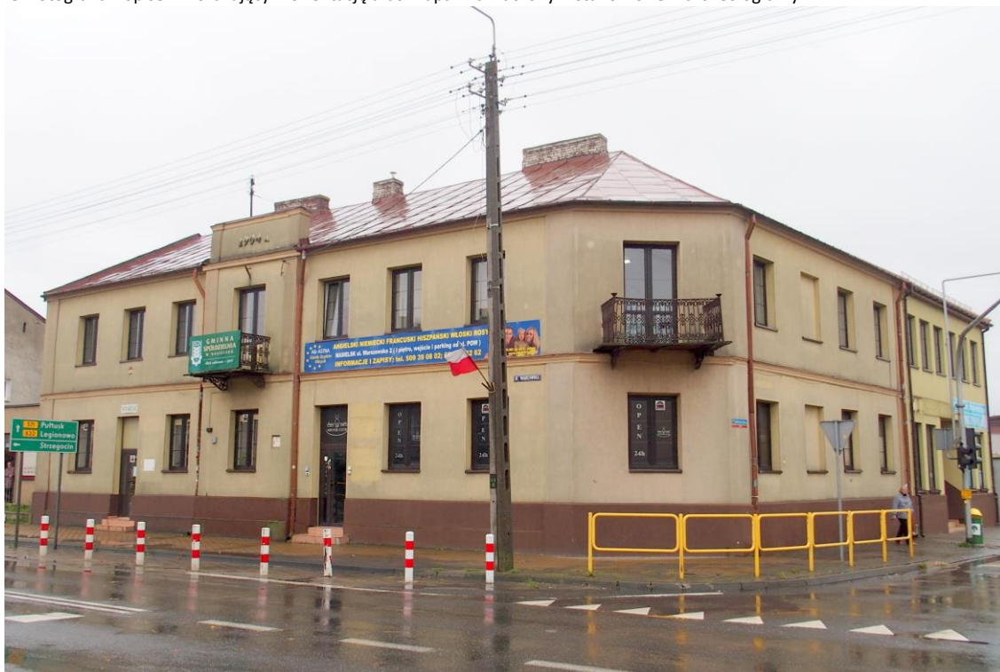
Widok budynku od północnego - zachodu
