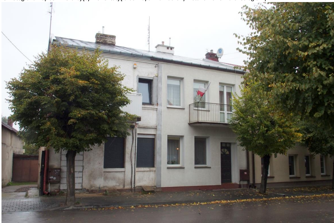
Widok budynku od południowego - wschodu
