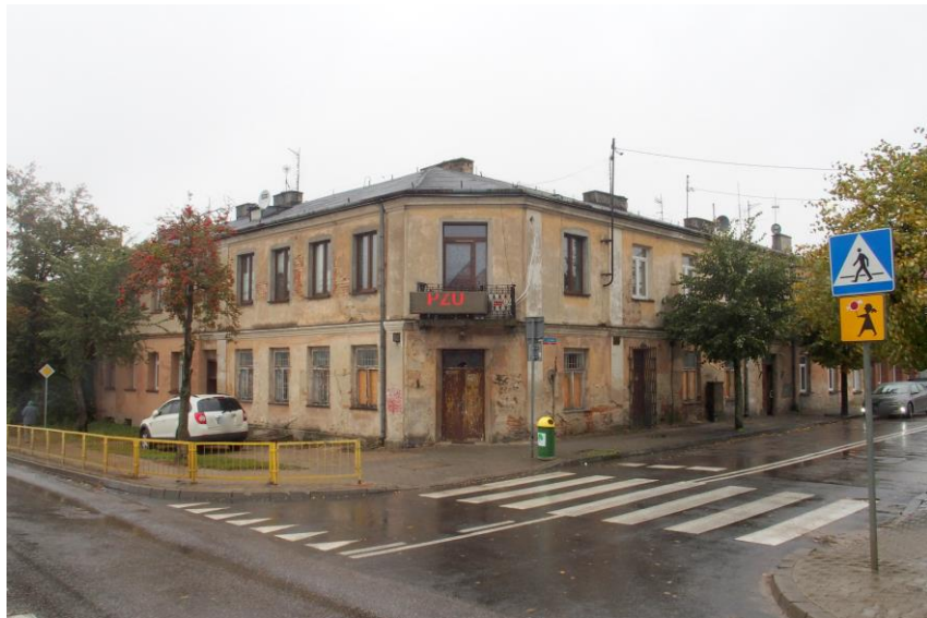
Widok budynku od południowego - wschodu
