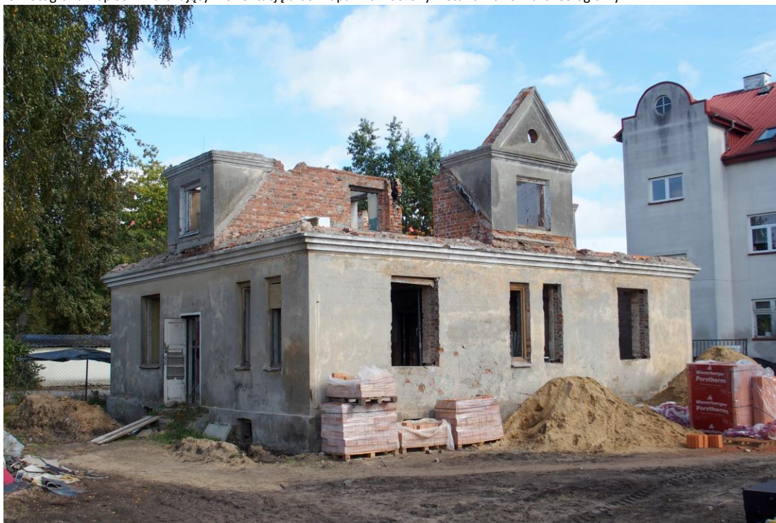
Widok budynku od południowego - zachodu
