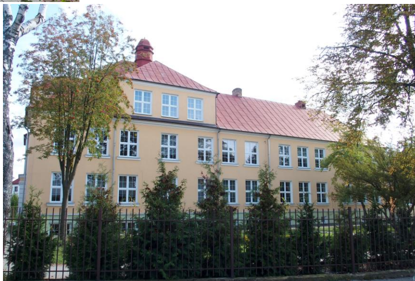
Widok budynku od północnego - zachodu
