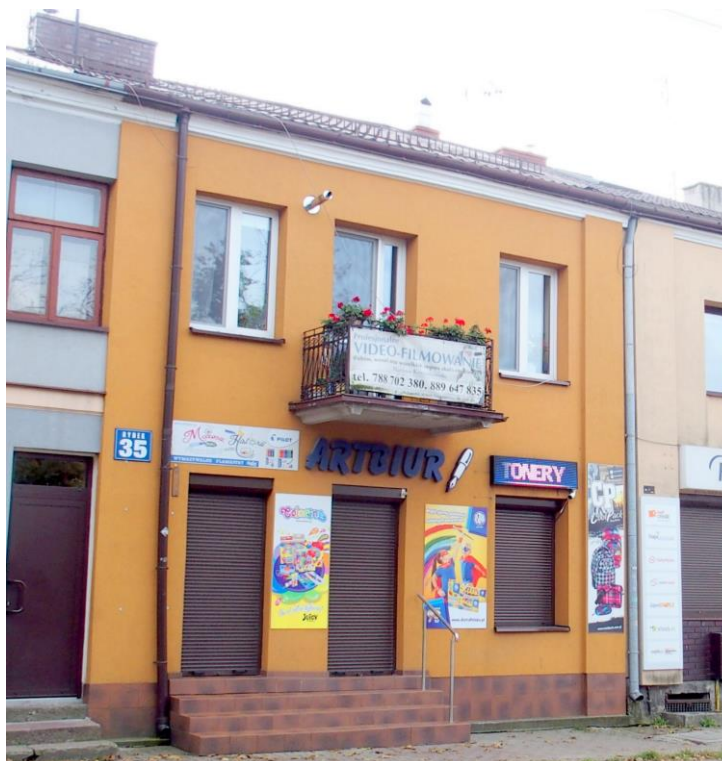
Widok budynku 35 od północy
