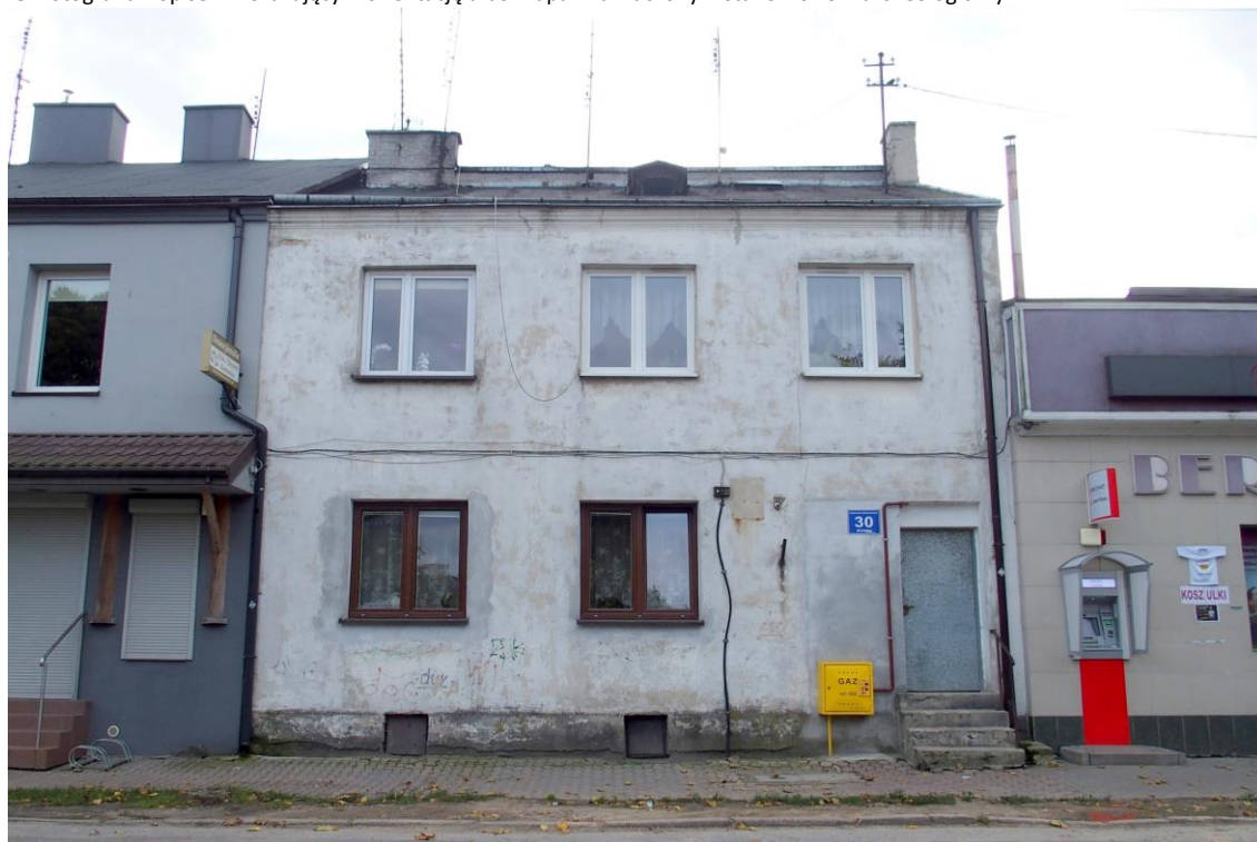
Widok budynku od północy
