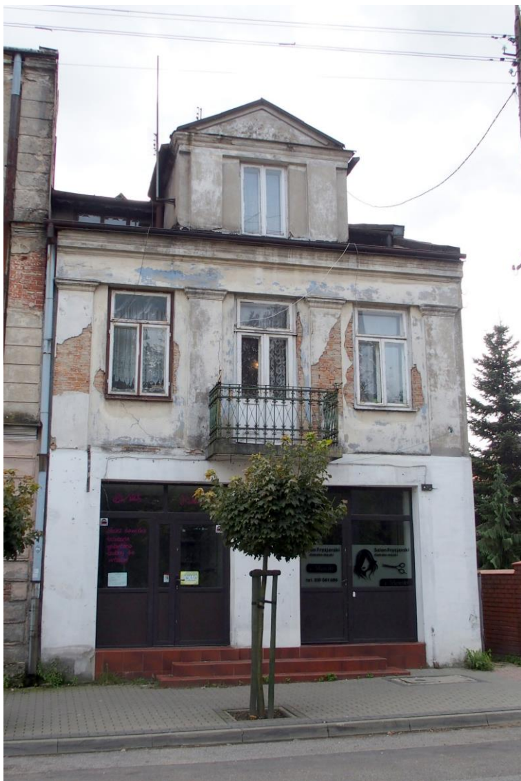
Widok budynku od północy
