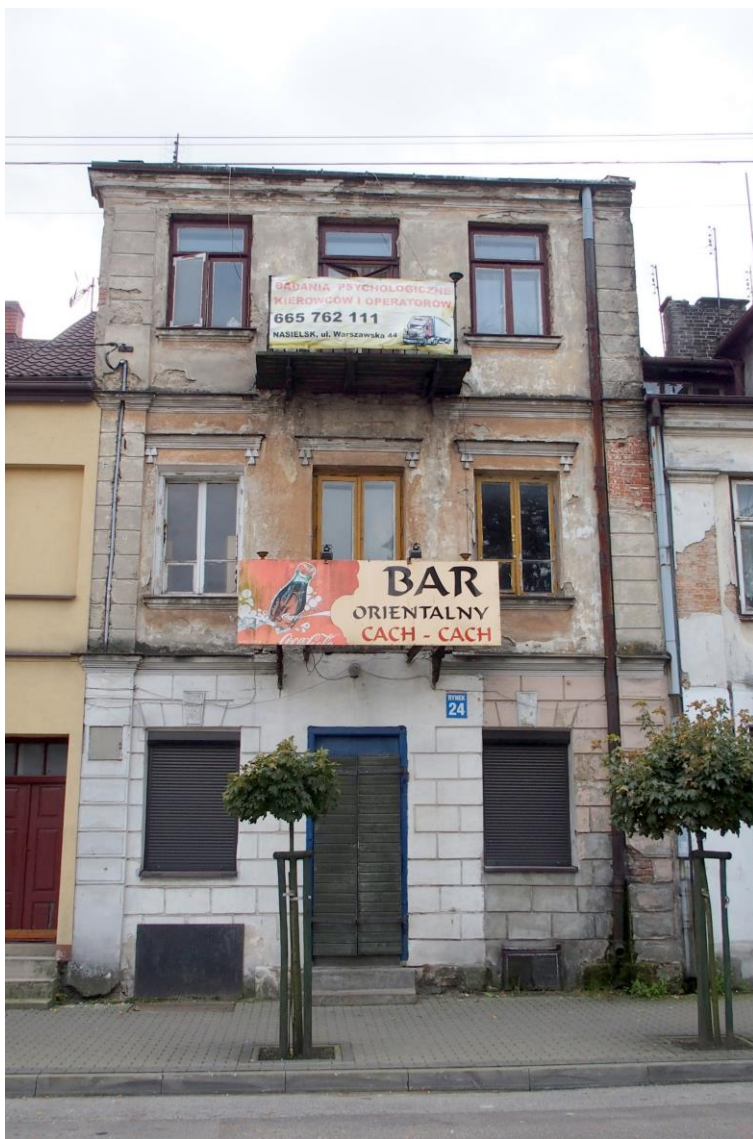
Widok budynku od północy
