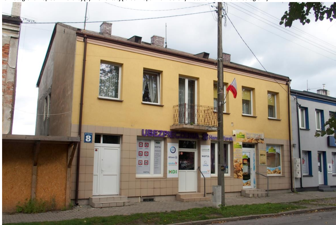
Widok budynku od południowego - zachodu
