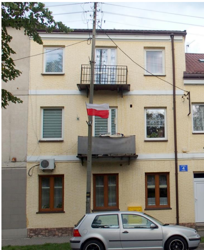
Widok budynku nr 4 od południa
