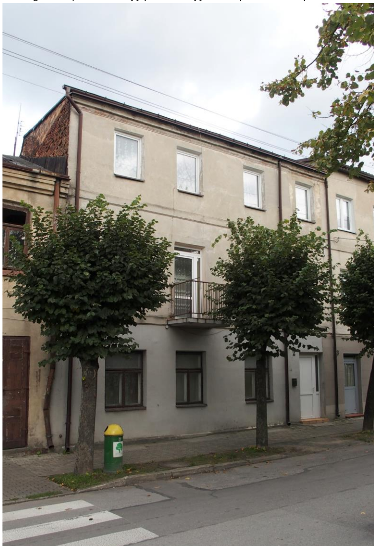
Widok budynku nr 2 od południowego - zachodu
