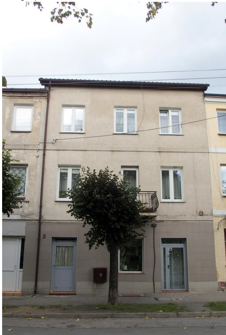
Widok budynku nr 3 od południa
