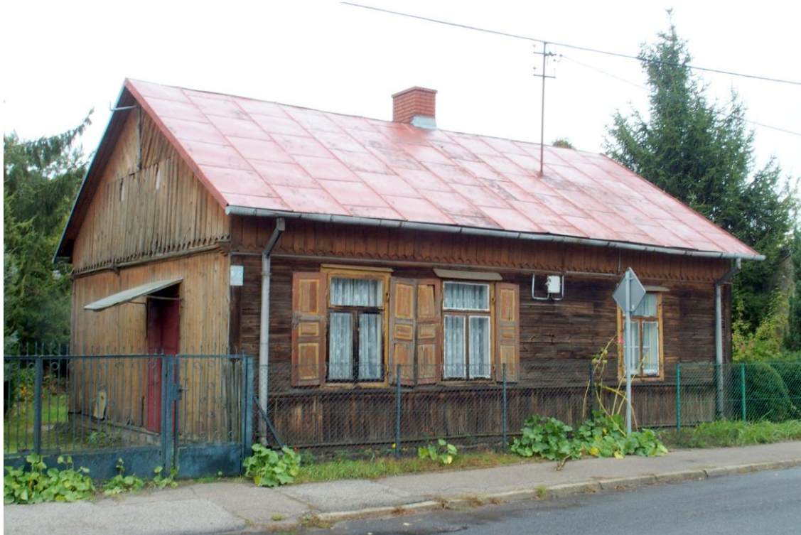
Widok budynku od północnego - zachodu
