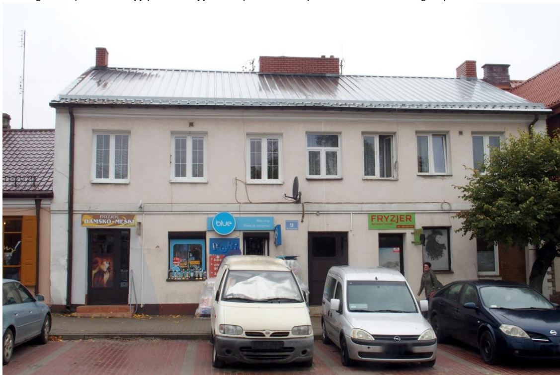
Widok budynku od wschodu
