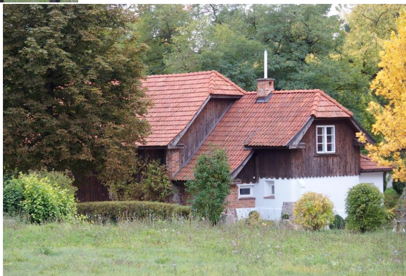
Widok budynku od północy
