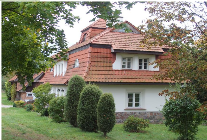
Widok budynku od północy
