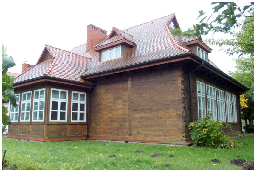
Widok budynku od północy
